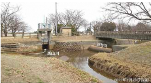
写真6 洪水調整堰とその周辺
