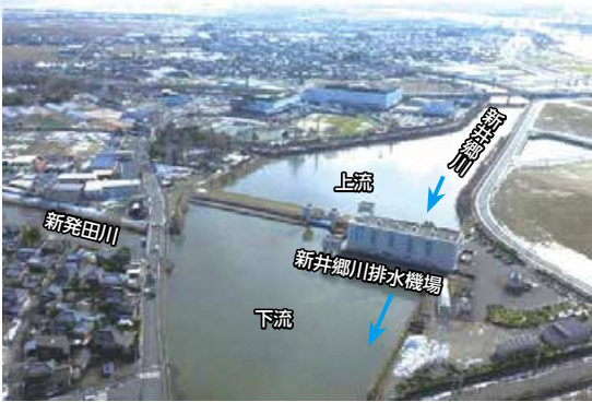
写真2 新井郷川排水機場
