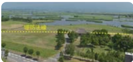
②福島潟堤防法線 (写真提供：新潟県)
