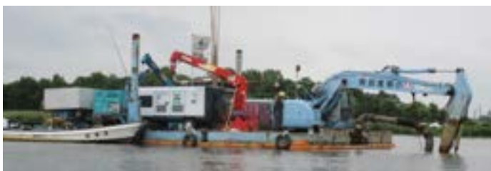
鳥屋野潟 重機による浚渫
