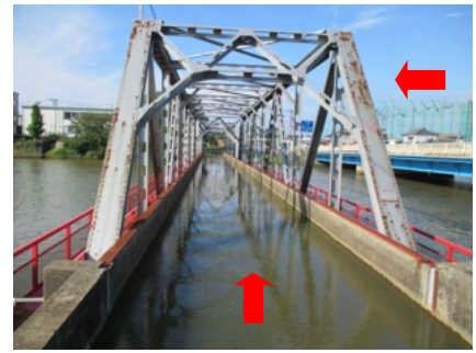
現在の内野新川立体交差
