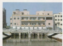
⑧排水の要となる親松排水機場
