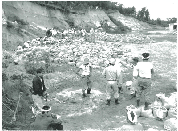
引越山を削って土のうを作る(昭和42年羽越水害) 北区郷土博物館提供
